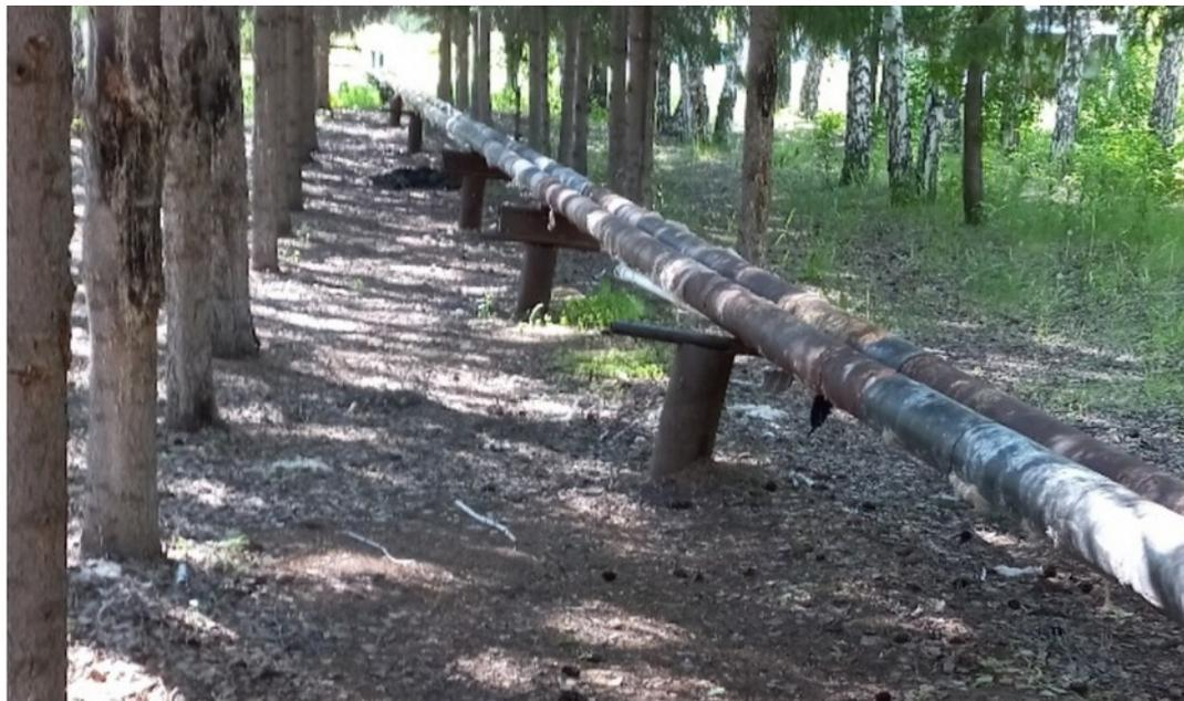
Рисунок 1 – Неизолированный участок сети до ответвления
