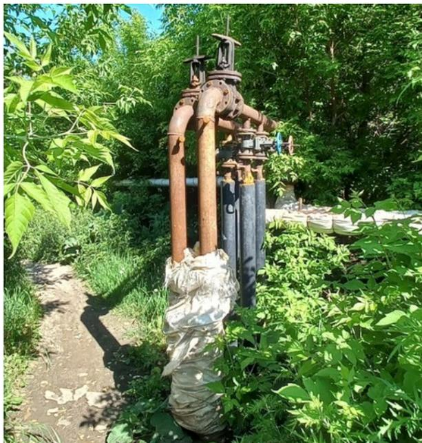
Рисунок 4 – Отсутствие тепловой изоляции на надземной части
