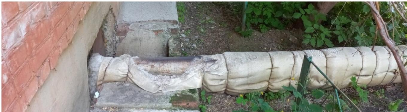
Рисунок 6 – Разрушение тепловой изоляции на вводе в МКД
