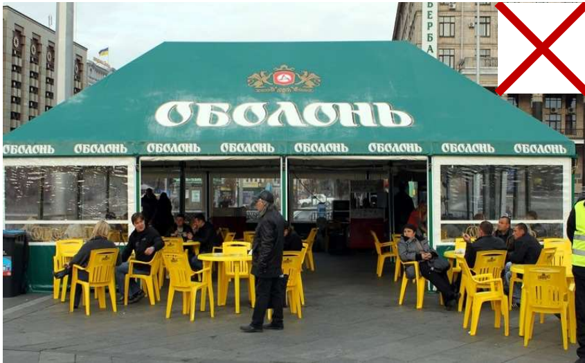
Размещение рекламы на крыше сезонного кафе, цвет шатра не считается с цветовой палитрой фасадов зданий
