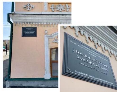
Пример размещения на здании
